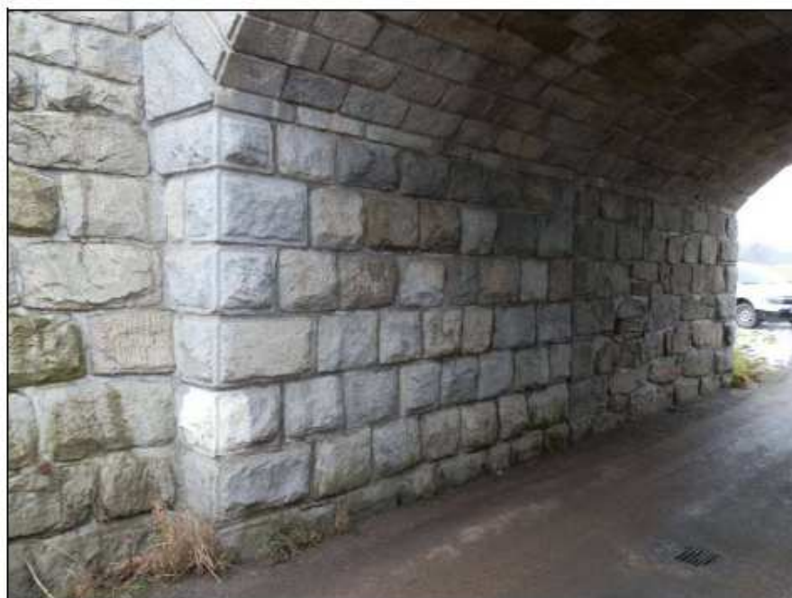
Obr. č. 5 - opěra Strakonice, zdivo je bez poruch, uprostřed opěry je dilatační spára po rozšíření objektu
