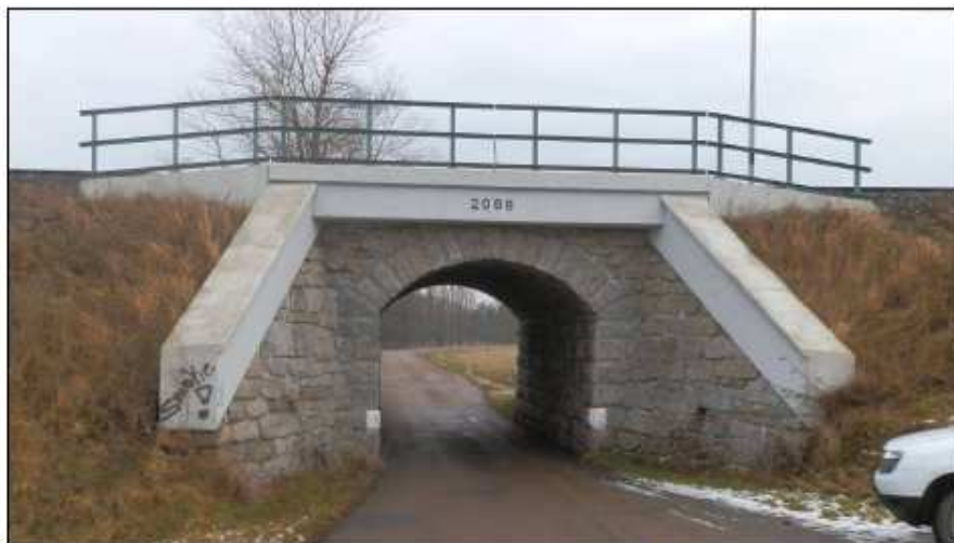
Obr. č. 3 - levé čelo objektu, zdivo je na viditelných částech bez poruch
