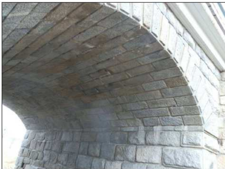
Obr. č. 6 - nosná konstrukce, klenba z levé strany, zdivo je bez poruch
