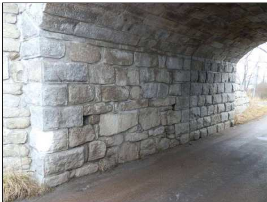
Obr. č. 4 - opěra Nepomuk, zdivo je bez poruch, uprostřed opěry je dilatační spára po rozšíření objektu
