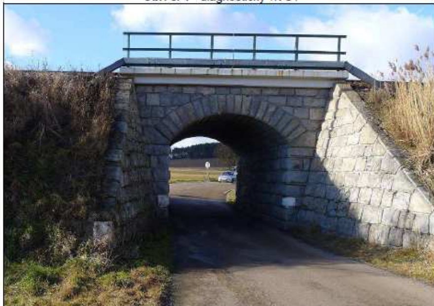
Obr. č. 2 - pravé čelo objektu, zdivo je na viditelných částech bez poruch
